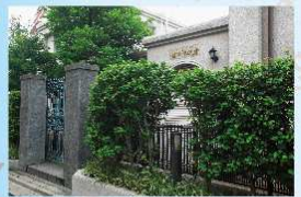
▲ 台東区立書道博物館 中村不折が私財を投じて建設した。昭和9(1934)年に竣工。書にかかわる貴重な資料が収蔵されている。(東京都台東区根岸)
