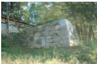
1 大手門跡石垣 高遠城に残る唯一の石垣。
