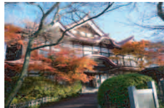
4 高遠閣 （国登録有形文化財） 昭和11年（1936）建築の休憩所。
